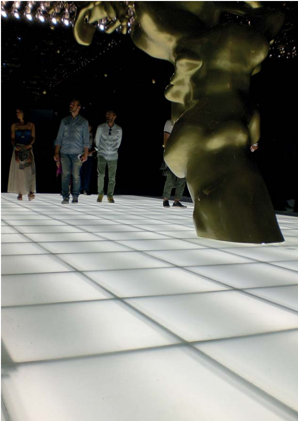
Boden aus rutschhemmendem Glas: Madras® Mod. Pixel Flooring 8 mm, klar, laminiert und hinterleuchtet. Expo 2015, Mailand, Wine Pavilion. Entwurf: Studio Italo Rota.. (Foto: Vitrealspecchi)
