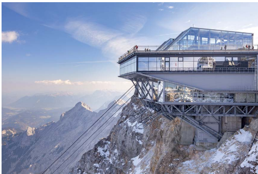
Die neue, spektakulär gelegene Bergstation der neuen Bayerischen Seilbahn Zugspitze bietet sowohl von innen als auch von der Gipfelterrasse grandiose Ausblicke in die umgebende Bergwelt. (Foto: © Vetrotech Saint-Gobain, Fotograf: Christoph Seelbach)
