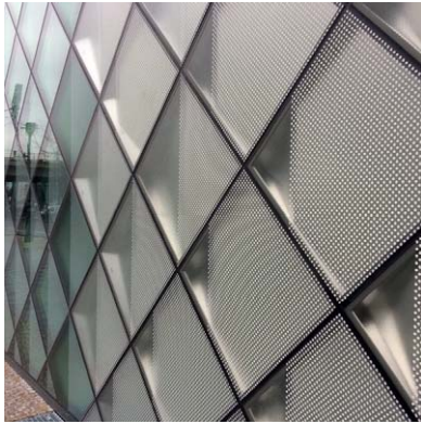
Blickpunkt Fassade: Das lichtstreuende Gussglas und die spiegelnden Reflexe von gefalteten Edelstahl-Reflektoren erzeugen ein vielfältiges Lichtspiel am Futurium (Foto: © Andreas Bittis/Saint-Gobain Glass).
