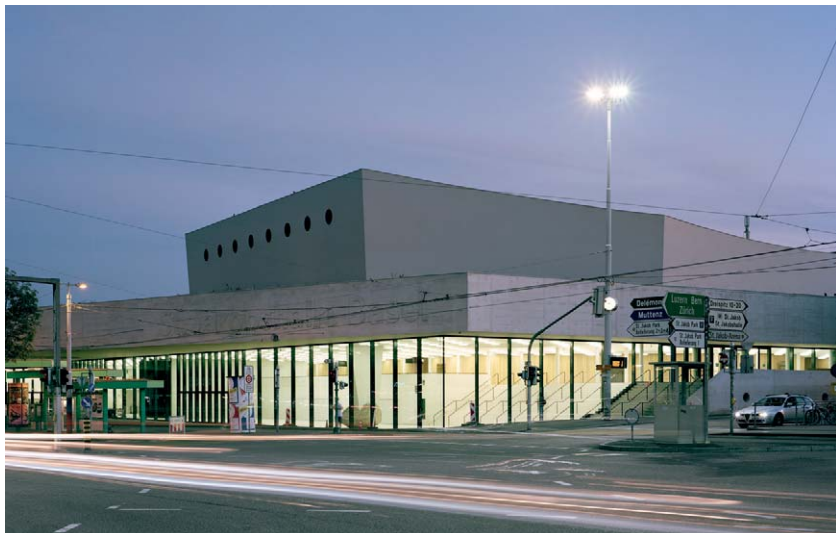
Transparent und licht: Die St. Jakobshalle in Basel nach grundlegender Sanierung und Umbau mit Scheibenformaten bis zu 6,5 × 2,8 Meter (© Barbara Bühler, Basel).
